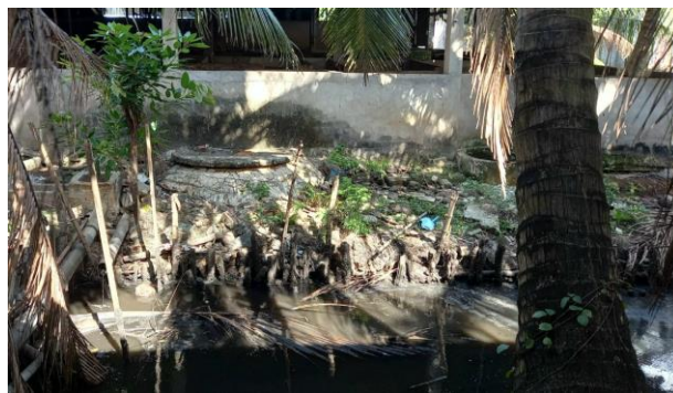
Hình 11. 02 hầm biogas và ao chứa 1
