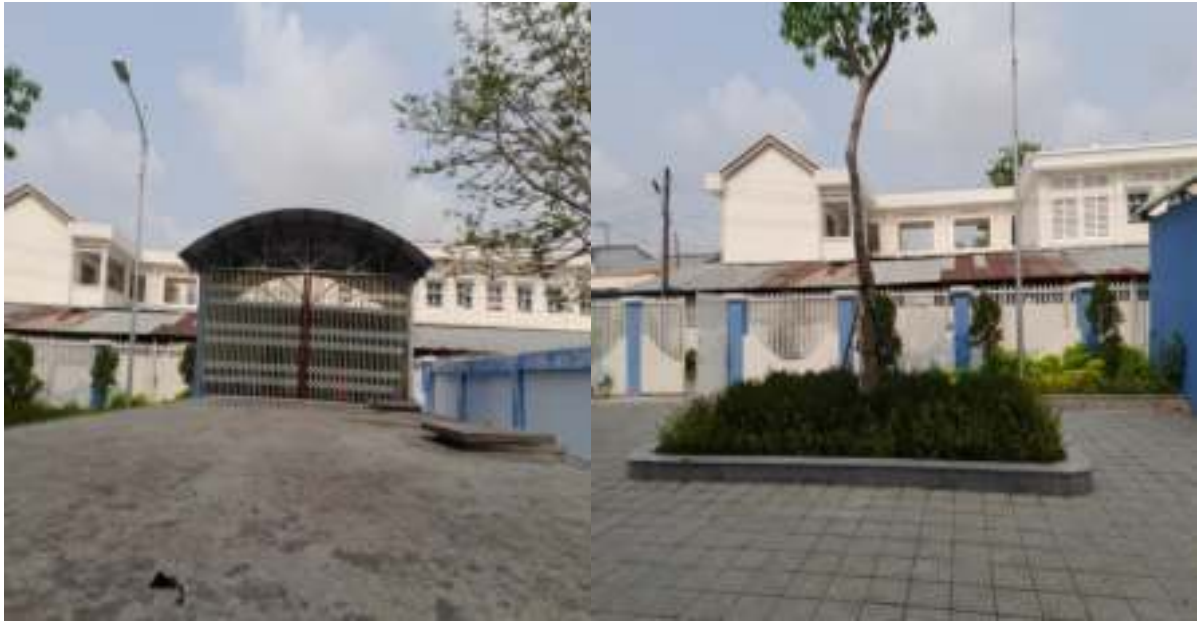
Hình 12: Nhà bao che máy bơm công suất lớn và cây xanh trong khuôn viên Nhà thi đấu đa năng huyện Châu Thành
