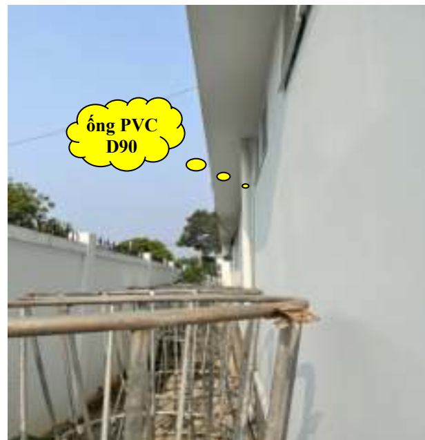
Hình 5. Ống PVC D90 dẫn nước mưa phần mái xuống sân đường (khu A)
