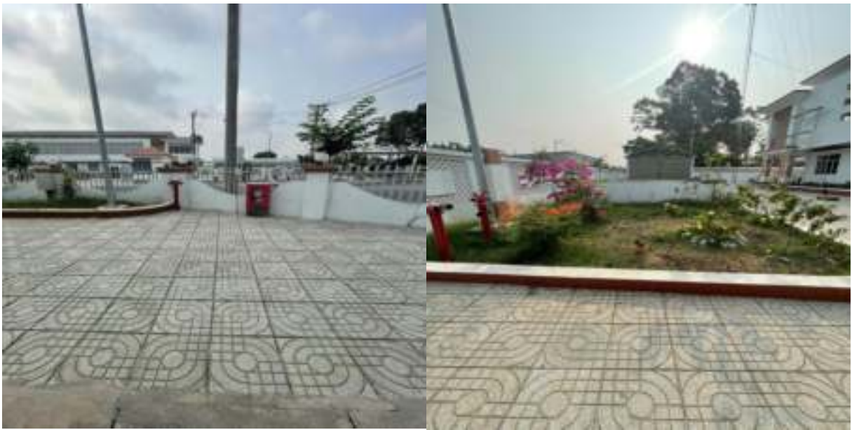
Hình 15. Công trình PCCC tại cơ sở
