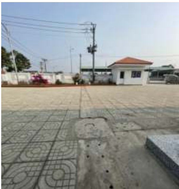
Hình 4. Cống thoát nước sân đường khu A
