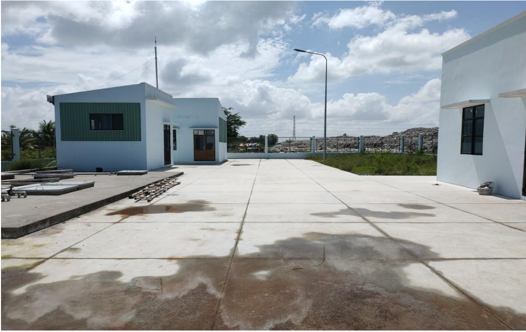
Hình 22: Hệ thống tường rào, cổng và sân đường nội bộ bê tông hóa
