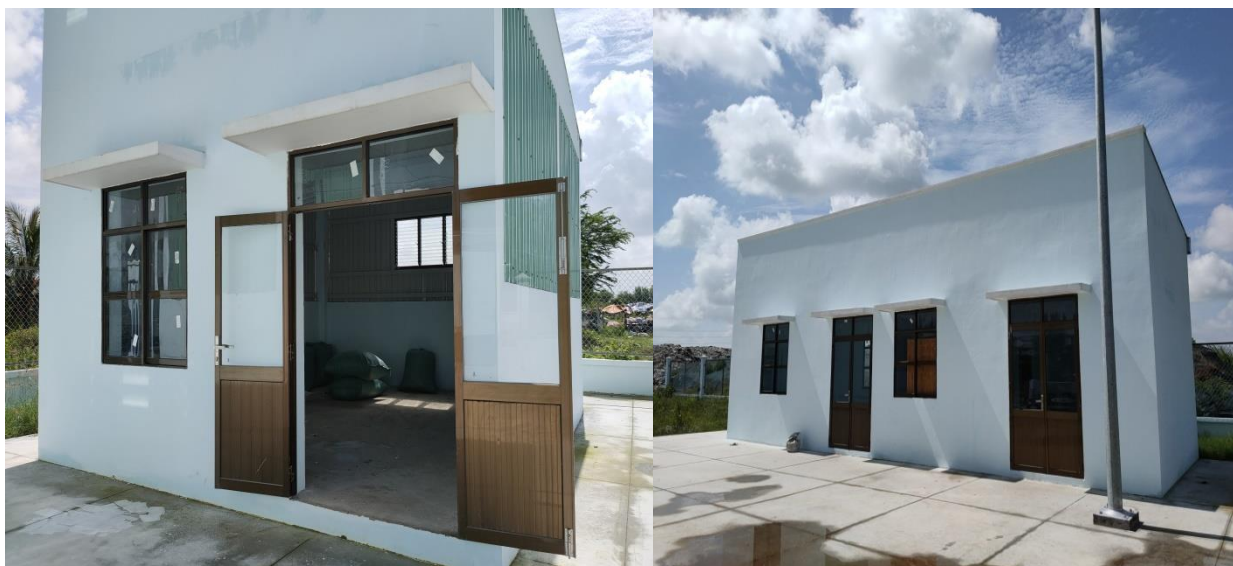
Hình 21: Nhà tập kết bùn khô, nhà kho vật tư và nhà điều hành
