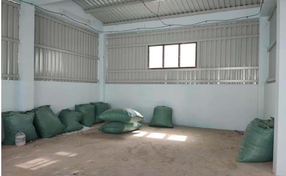
Hình 23: Nhà tập kết bùn khô sau khi ép bùn
