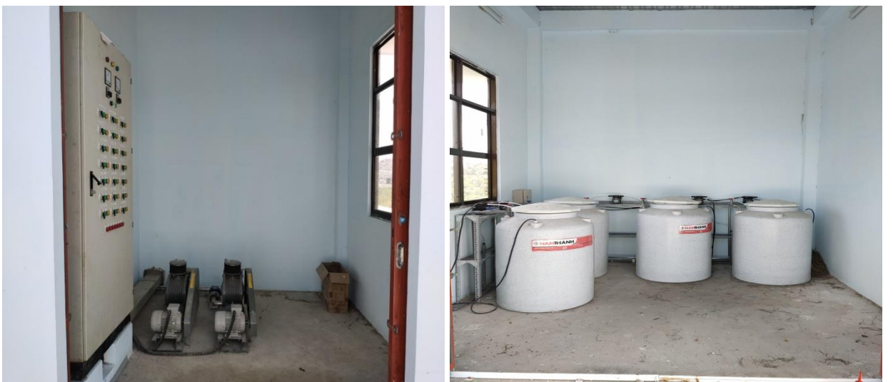
Hình 20: Nhà đặt máy thổi khí và bồn hóa chất
