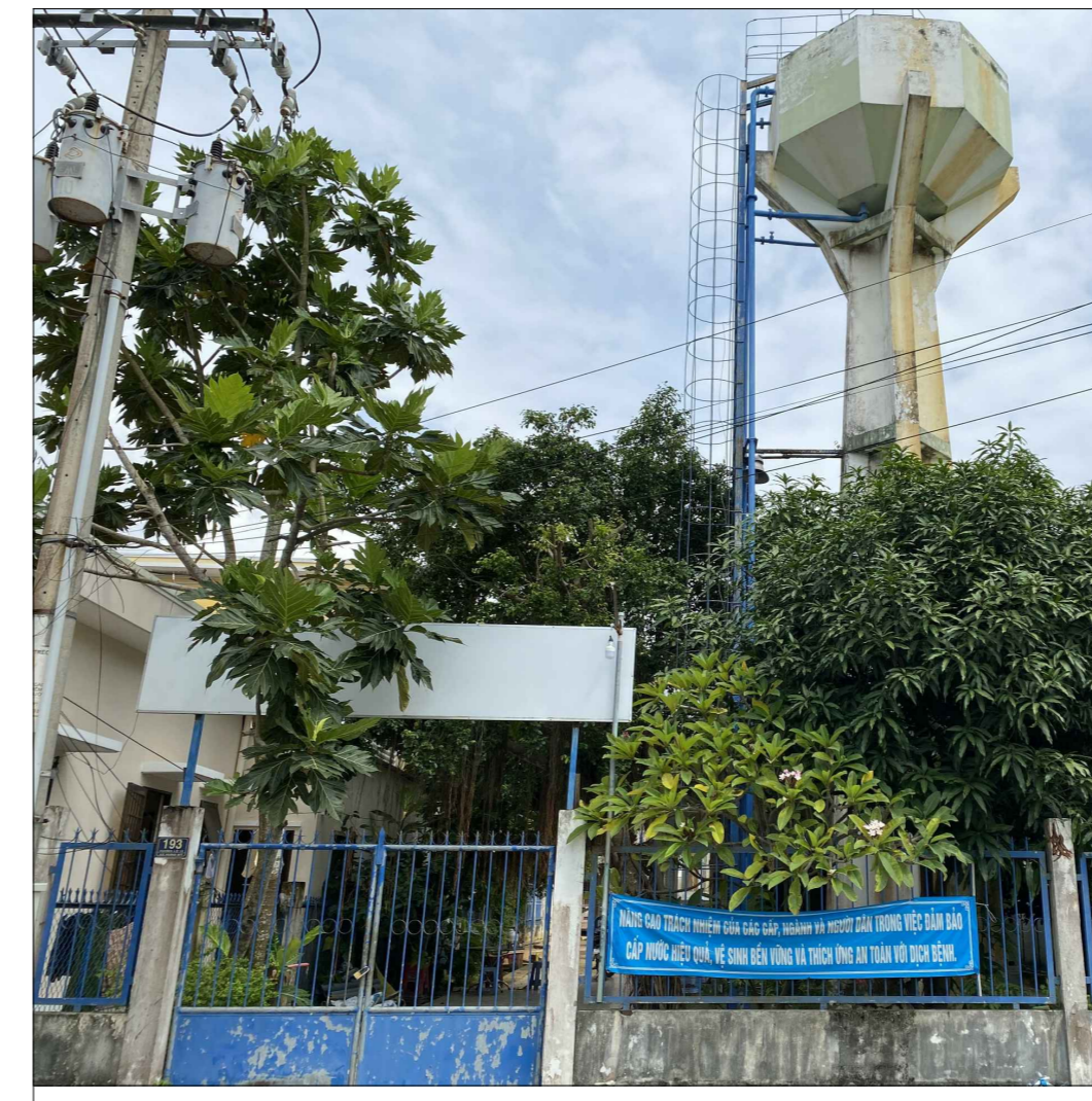
TRẠM CẤP NƯỚC XÃ HƯNG MỸ
