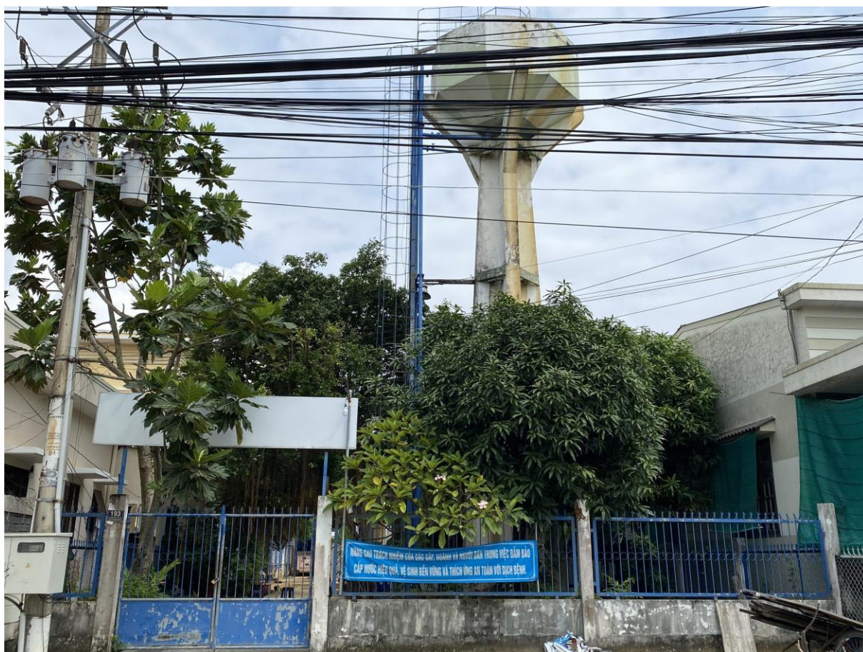
Hình ảnh 12: Hiện trạng trạm cấp nước xã Hưng Mỹ
