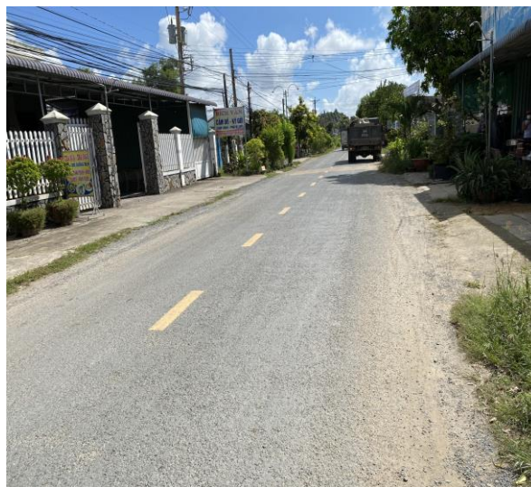
Hình ảnh 10: Hiện trạng Đường huyện 15.
